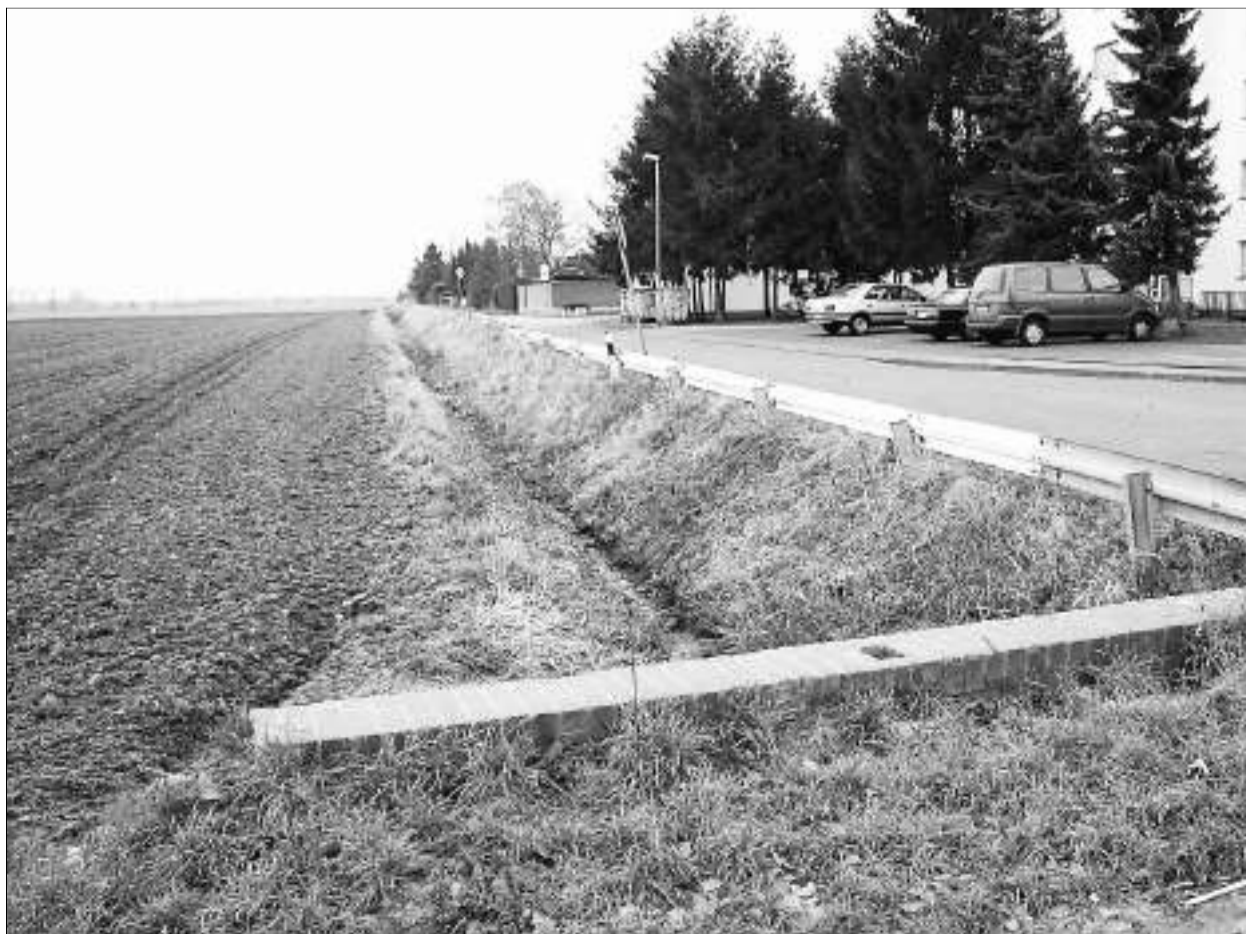
Das Giesendorfer Fließ gehört zu Wasserläufen, die den Regen von den Feldern zur Erft leiten. Es muss regelmäßig gepflegt werden, damit das Wasser ablaufen kann. (Foto: Kanzler)
